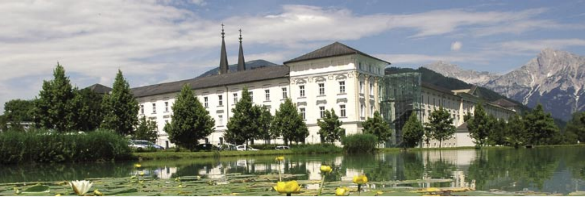
Benediktinerstift Admont • Ansicht von Südosten mit Stiftsteich
